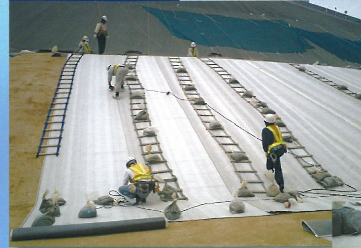
法面部接合状況
