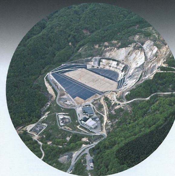
施工済み処分場 エコポート
